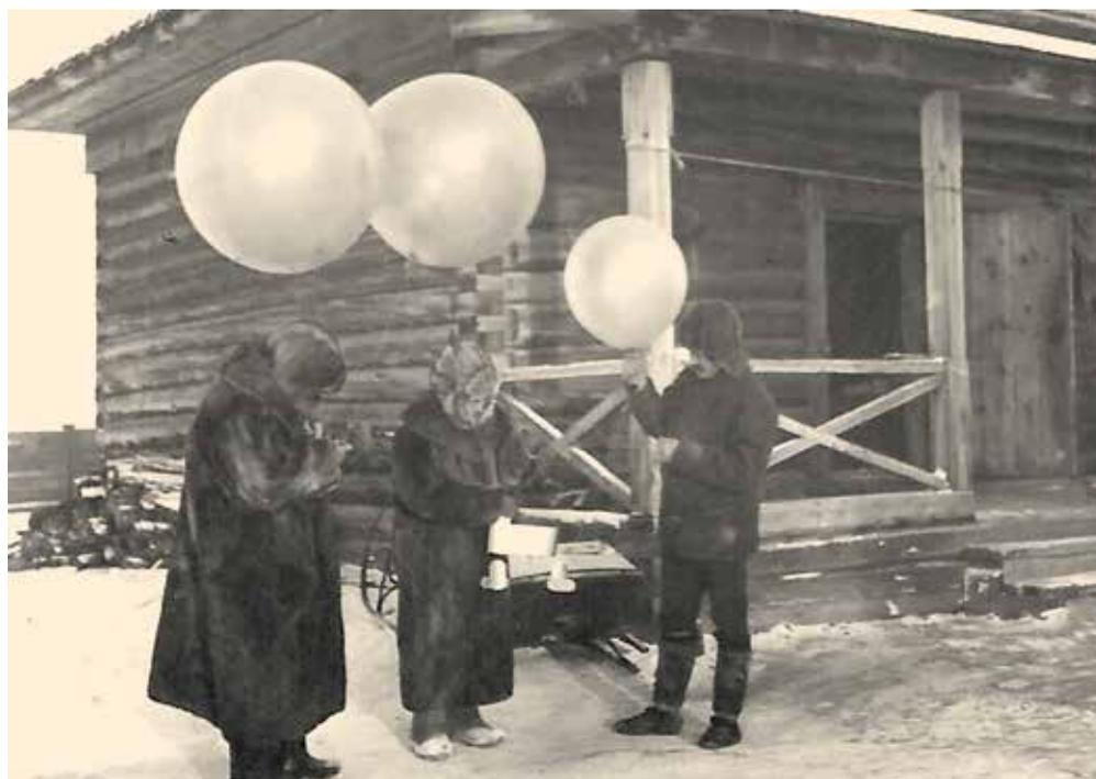
*Якутская аэростанция, подготовка к пуску шаров-пилотов для производства наблюдений
