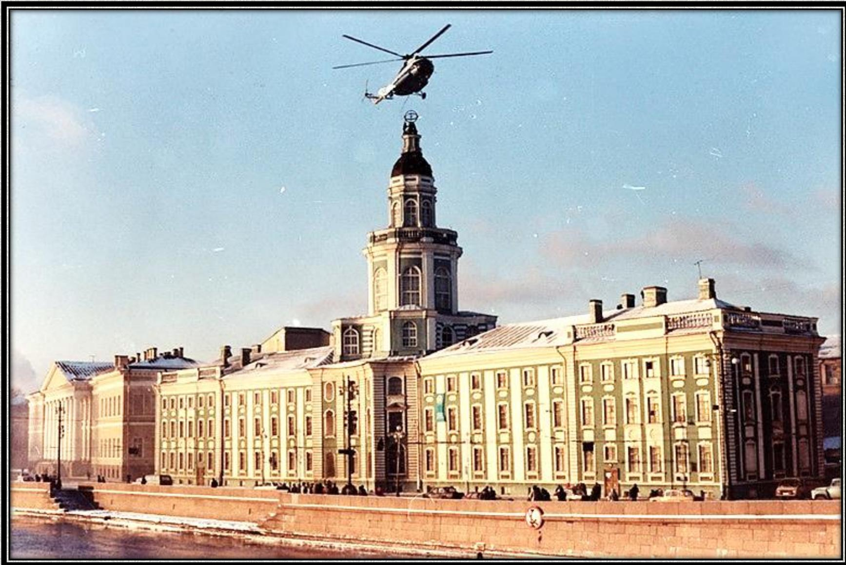
Установка 28 декабря 1993 г. на башне здания Кунсткамеры новой армиллярной сферы, спроектированной и изготовленной из титанового сплава в Центральном научно-исследовательском институте конструкционных материалов «Прометей».
